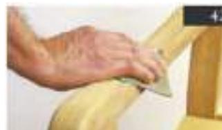
43. O acabamento do móvel é realizado com uma cobertura, especial para exteriores, aplicada com trincha.
