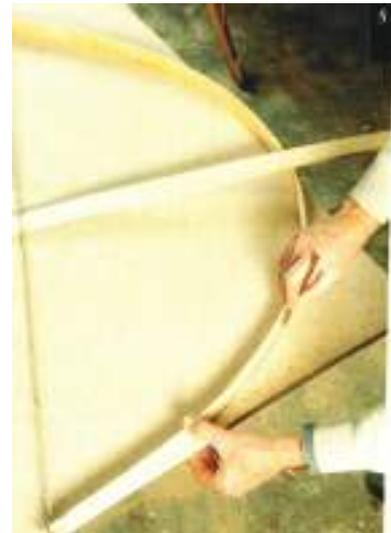
1. Traçado de um molde sobre uma placa de madeira mediante a sobreposição deste numa planta de oficina.
